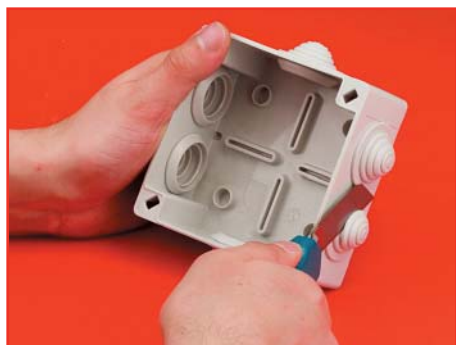
Срезаем кабельный ввод
