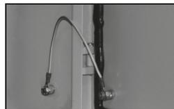
элементы заземления - на внешней двери корпуса и на монтажной панели
