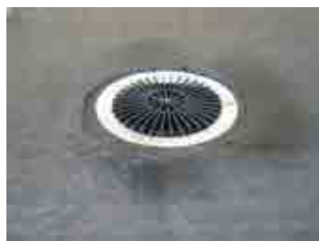
5. Так должна выглядеть воронка после укладки гидроизоляции
