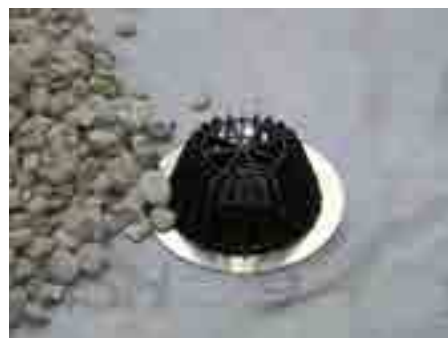
11. Установить листоуловитель, выполнить засыпку гравием (фракция: 20÷40 мм)
