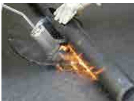
4. Наклеить 2-й слой гидроизоляции (до обжимного фланца)
