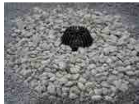
12. Засыпать гравием остальную поверхность кровли
