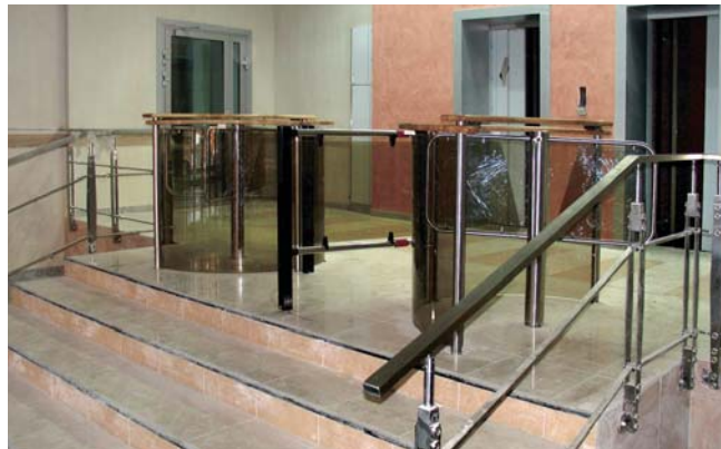
Примеры установок роторных турникетов с различными формирователями прохода
