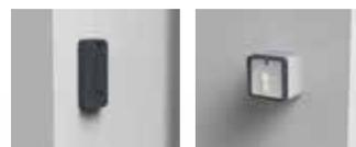
Фотоэлементы, установленные с внешней стороны объекта
