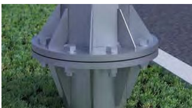
Фланцевое соединение
