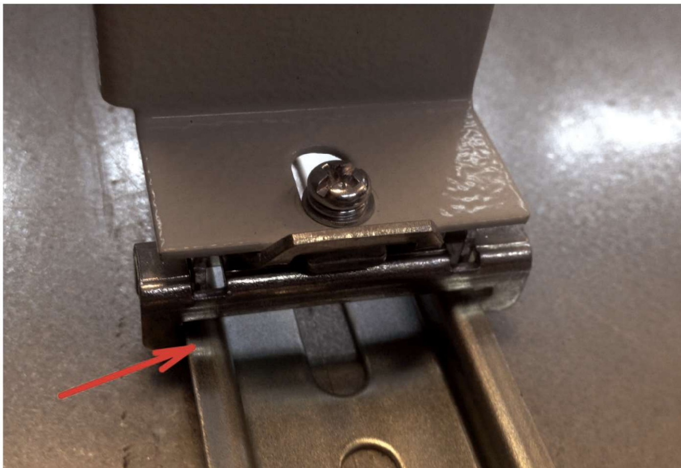
Рис.3.2-1 Положение крепления на din-рейку
