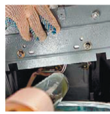
Замена блока ПРА
