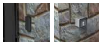
Фотоэлементы, установленные с внешней стороны объекта
