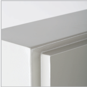
Полностью проваренные швы.
