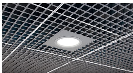
Установка светильника с переходником 300x300
