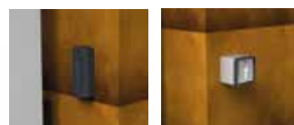
Фотоэлементы, установленные с внешней стороны объекта
