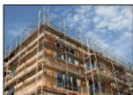
Монтаж строительных лесов
