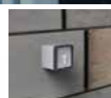
Ключ-выключатель, установленный с внешней стороны объекта
