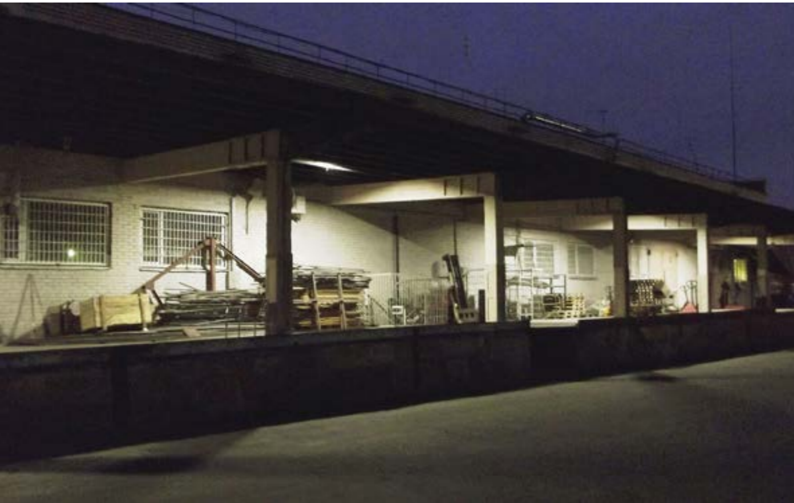
Освещение светильниками серии TUNNEL
