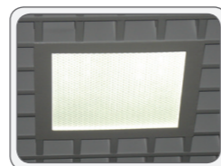
Монтаж в потолки Грильято
