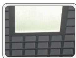
Монтаж в потолки Грильято
