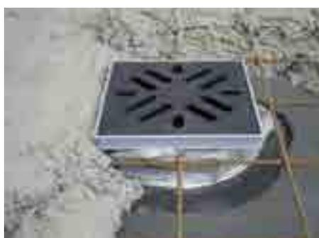
8. Залить бетонную стяжку
