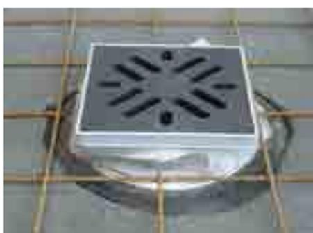
7. Надставной элемент обернуть фильтрующим материалом и уложить сетку из конструкционной стали
