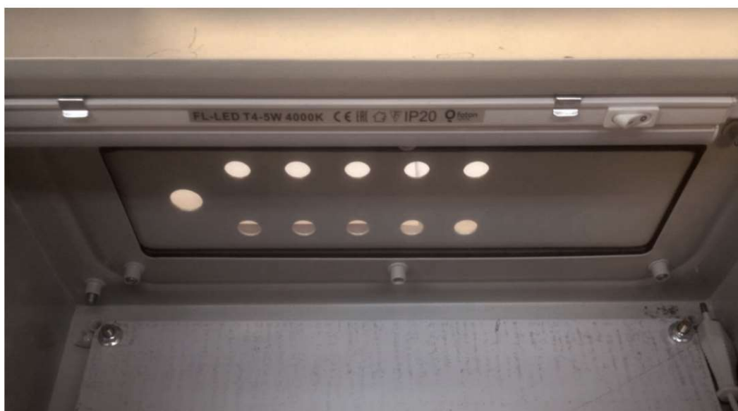
Рис.3.1.5-1 Установка светильника в корпус.
