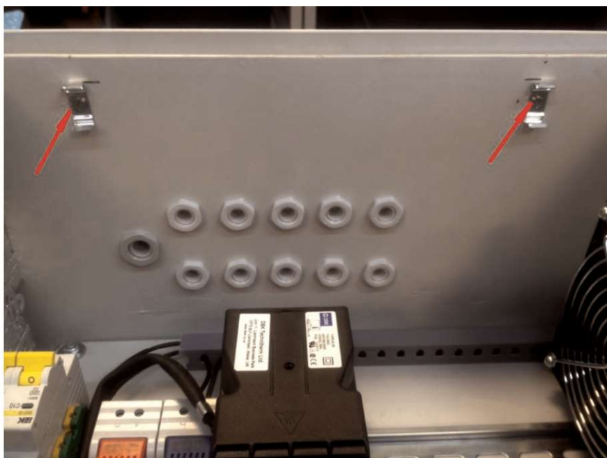
Рис.3.2.2-1 Установка пружинных креплений шкафа OSP.
