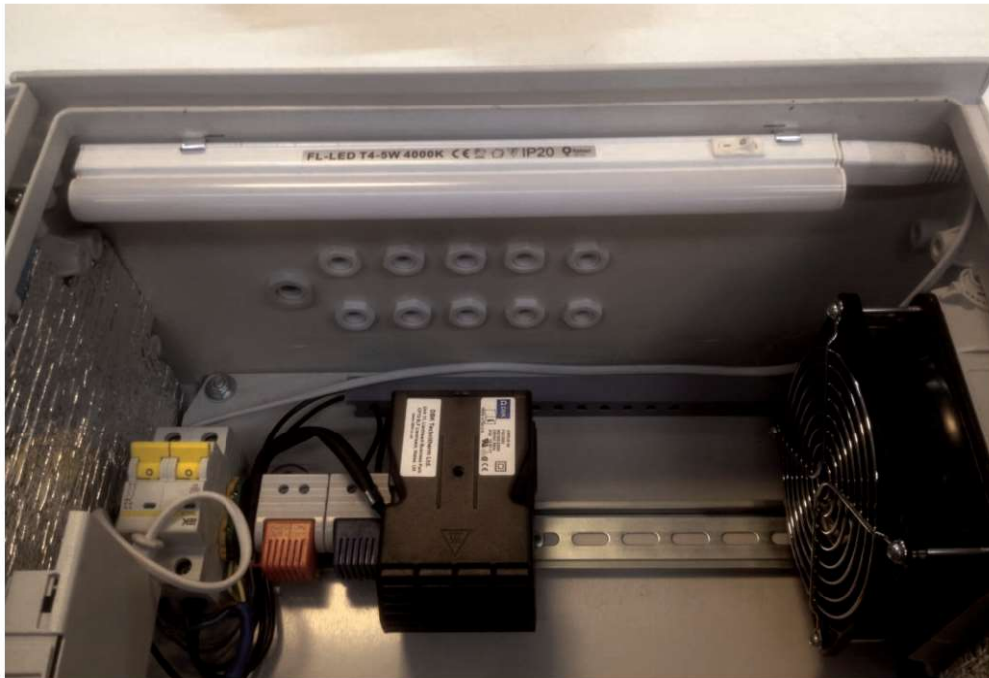
Рис.1-3 Установка светильника в уличную станцию в пластиковом корпусе.
