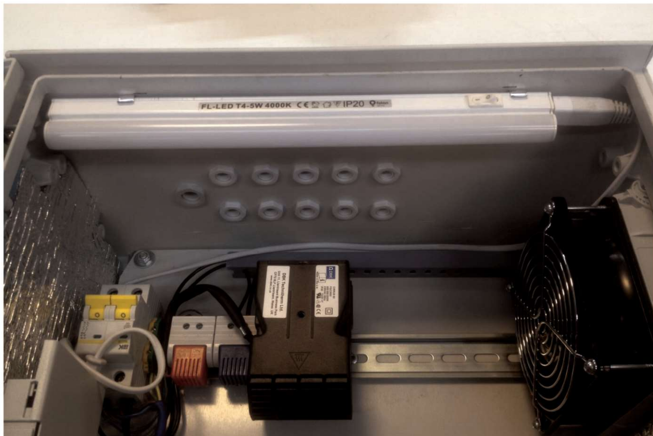
Рис.3.2.3-1 Светильник установленный в пружинные крепления шкафа OSP.
