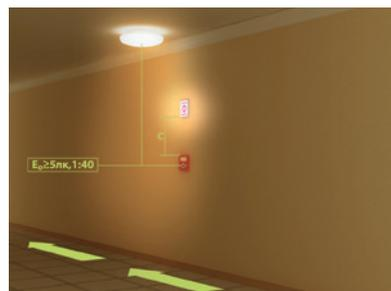
Питание световых указателей в нормальном режиме должно производиться от источника, независимого от источника питания рабочего освещения, а в аварийном режиме переключаться на питание от третьего независимого источника, например
